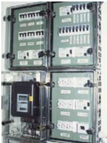
Ordnungsgemäßer Stromkreisverteiler
